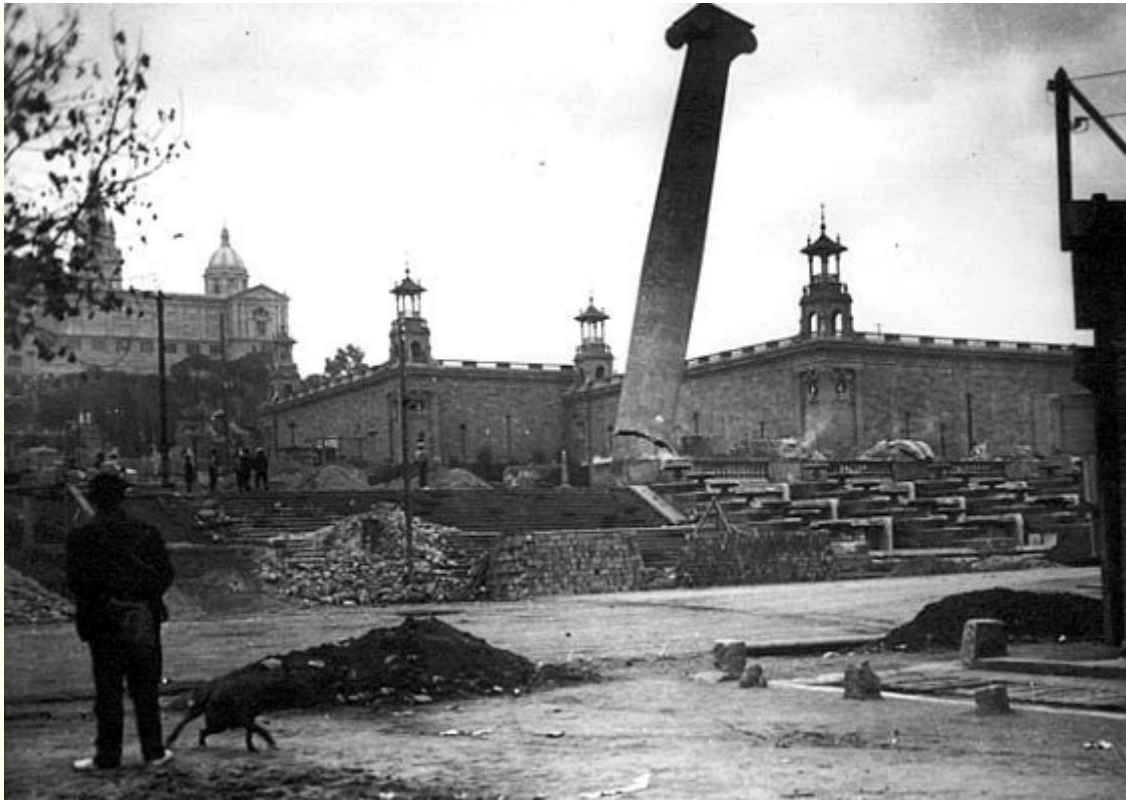
Demolició de les columnes de Puig i Cadafalch
